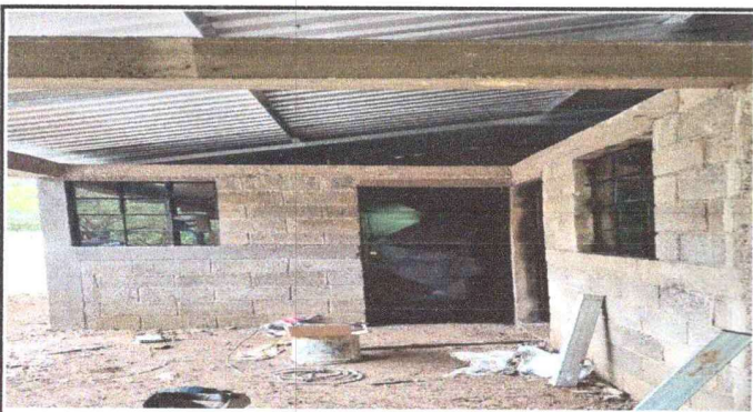
Foto 3: Instalacion de puertas, ventanas y vidrios.
